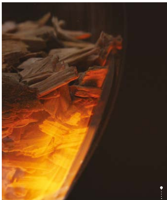
La chaufferie fonctionne avec le bois local.
