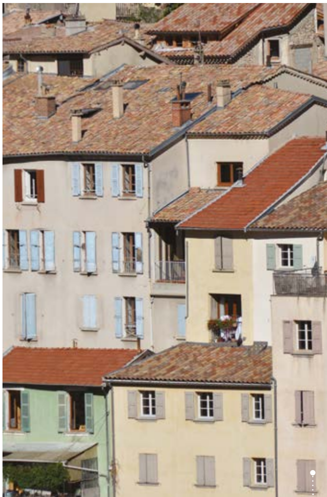
150 logements rénovés en trois ans.
