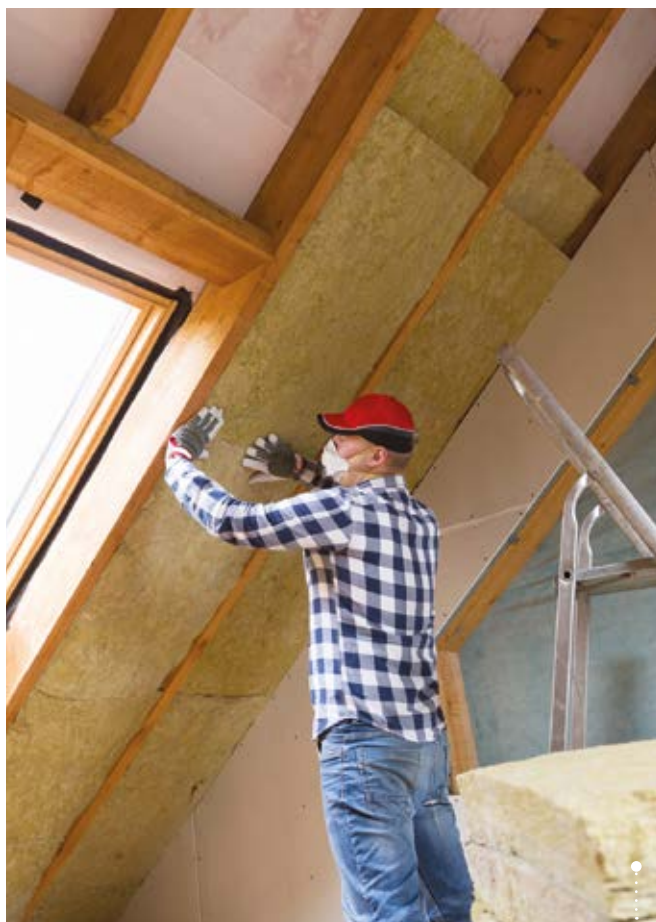
Isoler pour dépenser moins d'énergie en chauffage.
