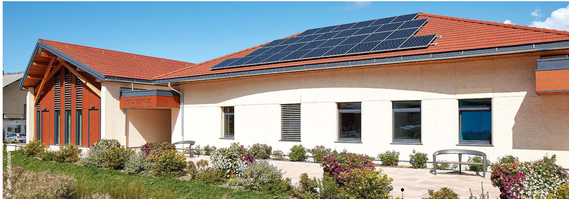
La construction du bâtiment qui accueille, entre autres, la médiathèque de Chabottes a bénéficié de l'expertise d'IT05.
