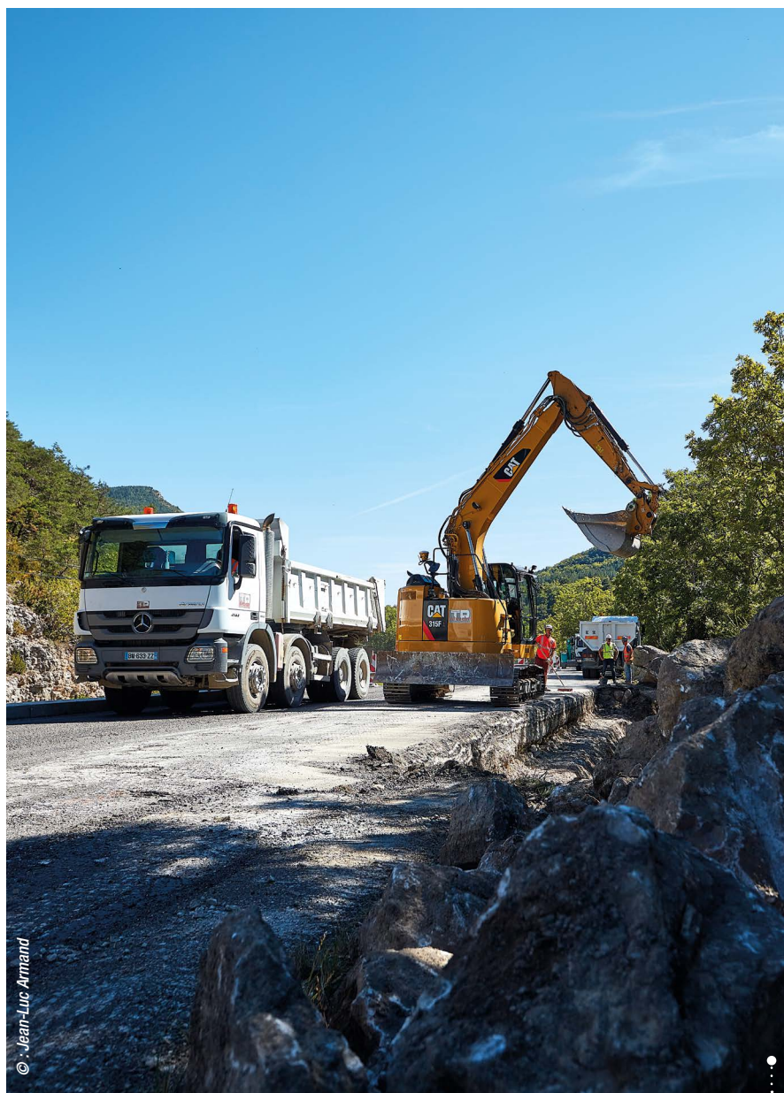
Le réseau routier départemental bénéficie régulièrement de travaux afin de sécuriser les itinéraires et de faciliter les déplacements comme ici sur la RD 1075.
