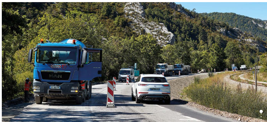
La RD 1075 est l'un des axes routiers qui vont être modernisés. ...
