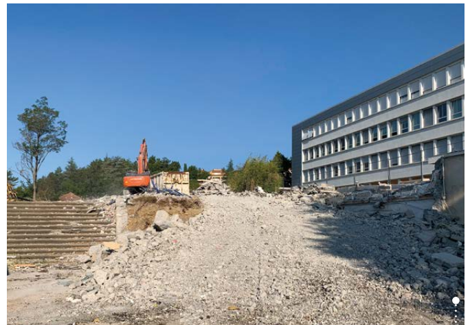
Les gravats évacués au plus vite pour ne pas perturber la rentrée.
