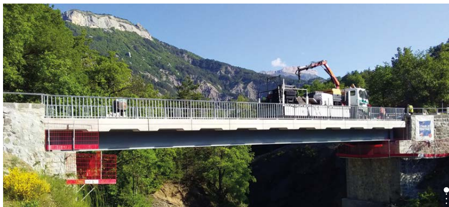
Un nouveau tablier pour le pont des Esclots.
