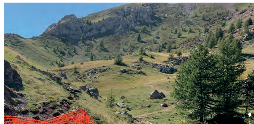
Le sentier d'accès au Pic du Morgon réhabilité et sécurisé.
