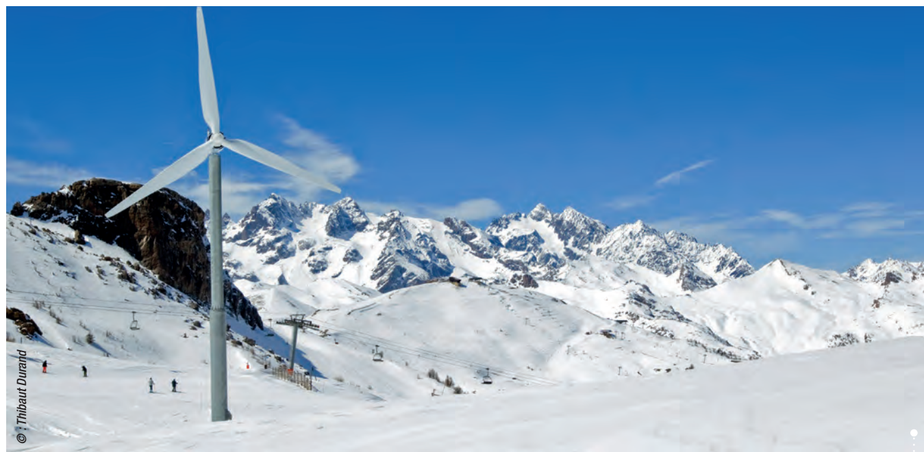
La station de Serre-Chevalier va autoproduire 30 % de sa consommation électrique.
