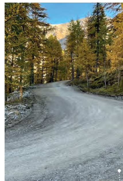
La première phase des travaux est achevée.
