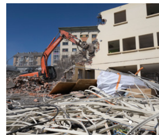
Démolition de la MDS de Guillestre.
