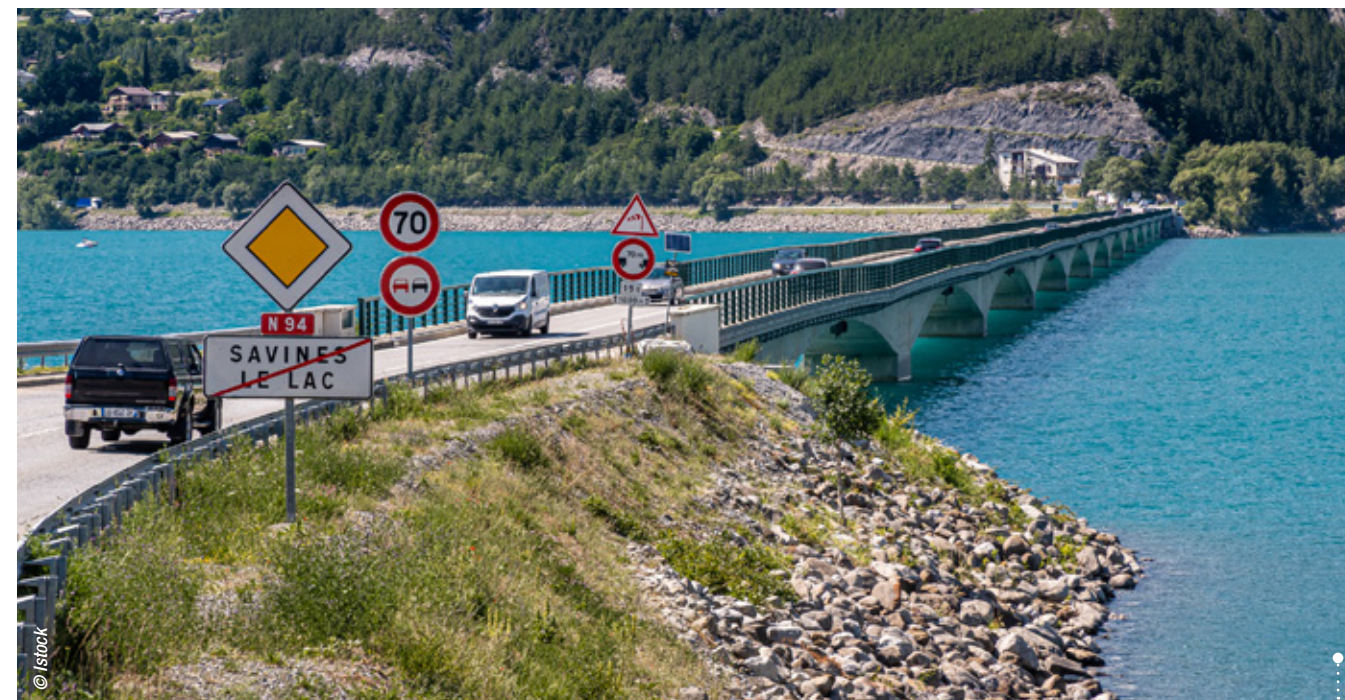
Les financements accordés par l'État seront-ils suffisants pour réaliser les grands travaux programmés sur les nationales, comme ici le pont de Savines ?
