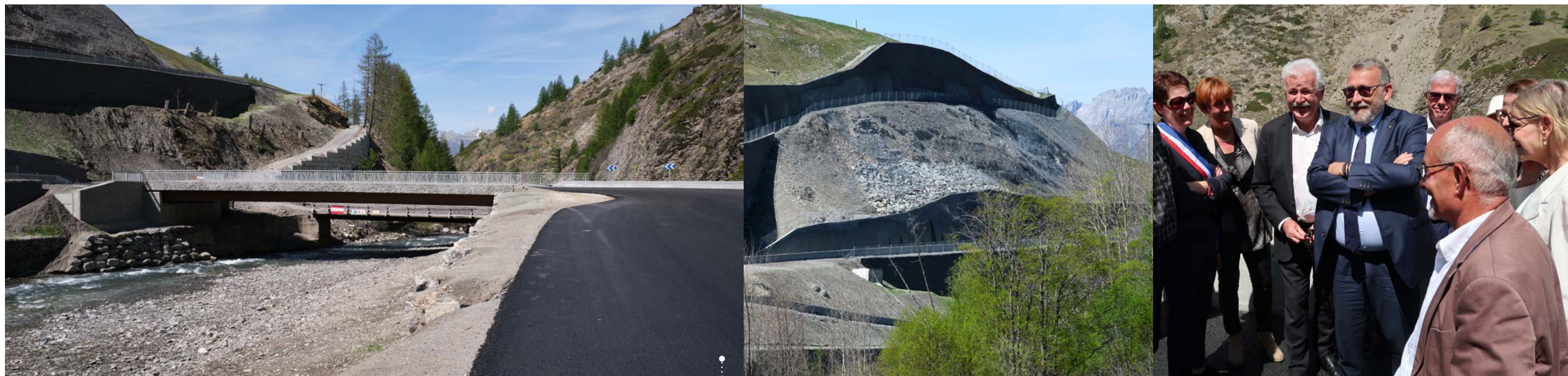
Une nouvelle route, des parois clouées et deux ponts ont dû être construits pour que la circulation soit à nouveau fluide sur la RD 947.
