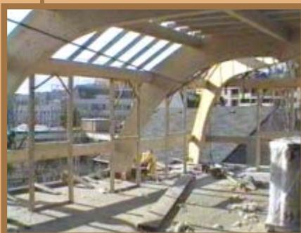
La toiture est une partie importante de la construction de cet édifice. Elle est composée d'une charpente en bois sur laquelle repose une couverture en ardoise. Cette couverture est issue de matériaux récupérés lors de la déconstruction de l'ancien Évêché.
