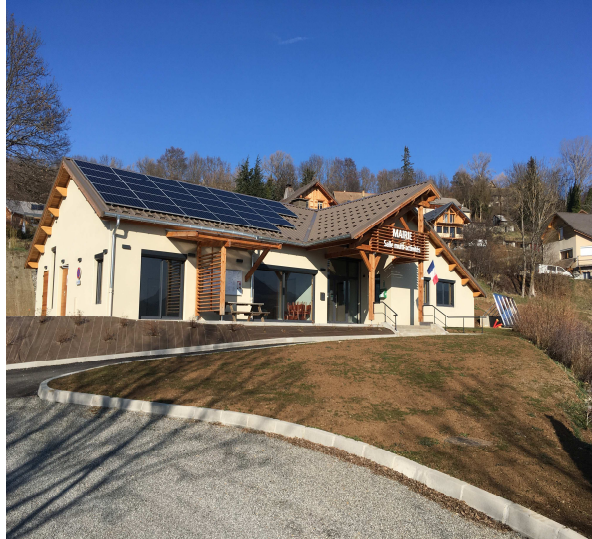
Construction d'une mairie et d'une salle multi-activités à Buissard
